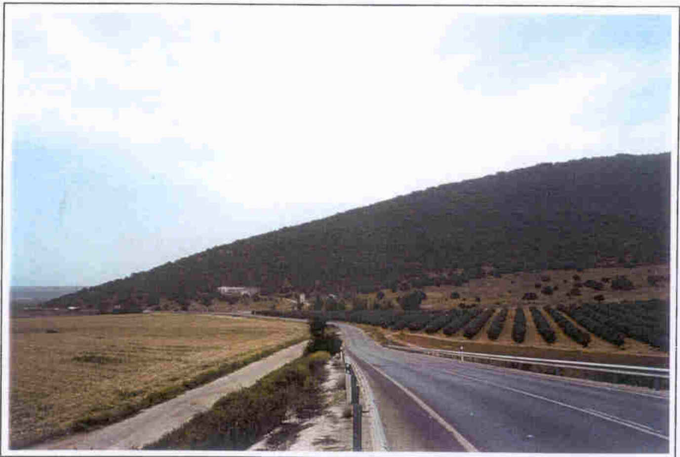
F-2.-Ladera meridional de la sierra
